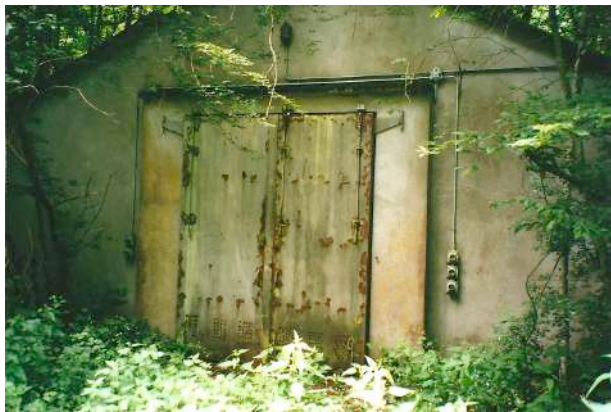
Figure 2 Un abri à munitions à l'intérieur du dépôt de l'ancienne base de Juvaincourt, dans le "Bois Pralet" Photographie P. Labrude, 2012
