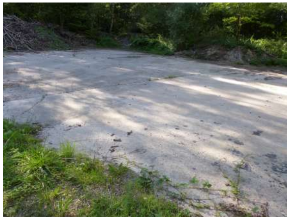
Figure 19 Une aire bétonnée dans la forêt de Gobessart Photographie P. Labrude, 2019
