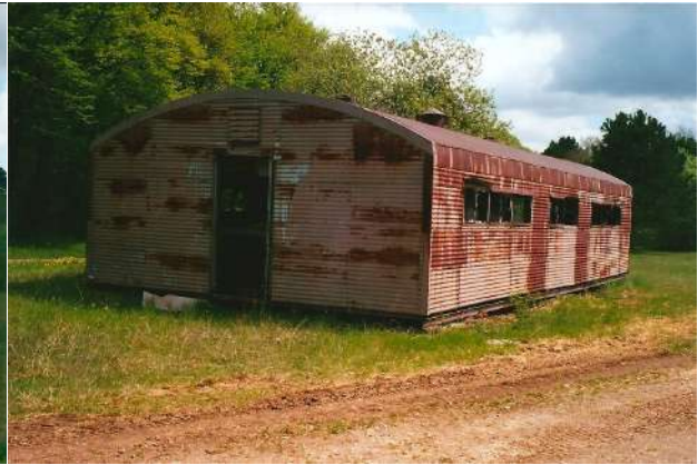
Figure 12 Le shelter d'habitation du dépôt de Martigny-les-Gerbonvaux Photographie P. Labrude, 2008
