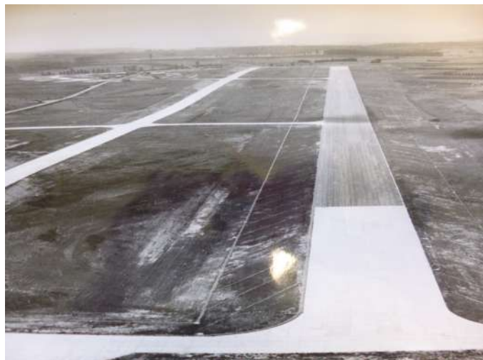
Figure 1 la piste de la base de Juvaincourt en construction (1954) Archives départementales des Vosges, 1000 S 835 Photographie P. Labrude
