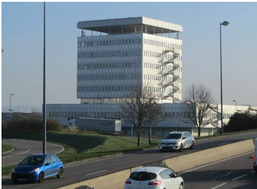
Document 3 : La tour des coopérateurs. Architecte Louis Fleck. Les escaliers extérieurs ne sont pas d'origine et dénaturent quelque peu l'édifice. Celui-ci a échappé à la destruction en raison du coût de démontage lié à la présence d'amiante (Cliché J.-M. Simon, 2016).
