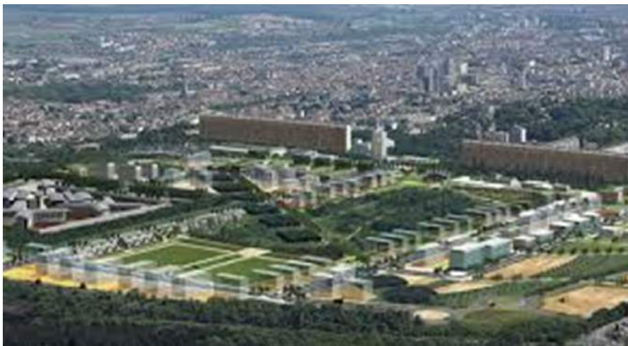
Figure 4: vue axonométrique du quartier et du parc central. (Croquis agence Alexandre Chemetoff)
