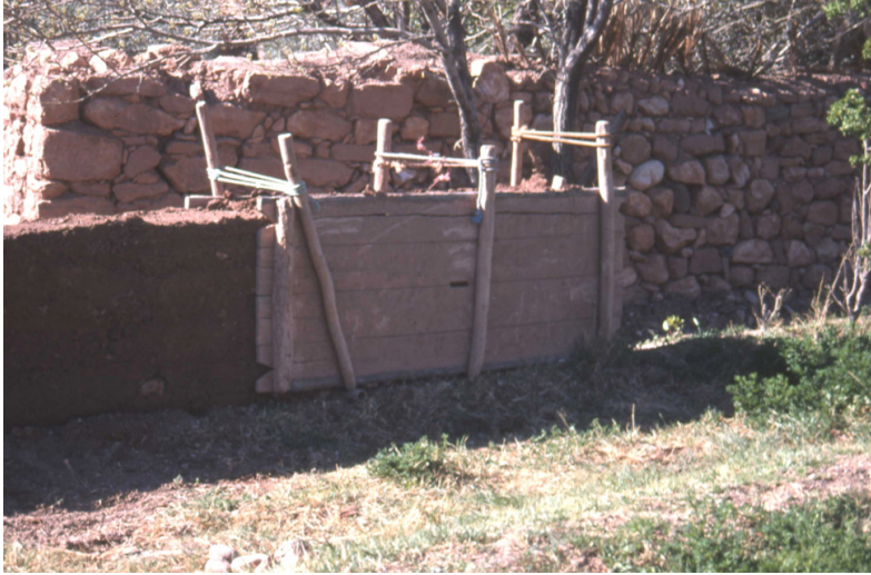
Fig.4 - Construction par banchée ( Cliché Gérard Giuliani )
