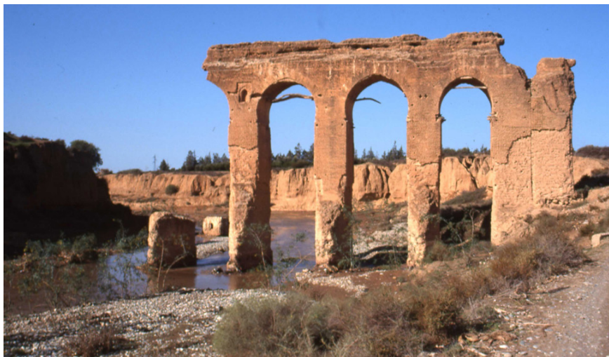
Fig.2 - Aqueduc sur l'oued Ouaar ( Cliché Gérard Giuliano )
