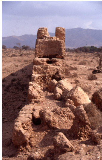
Fig.6 - Aqueduc effondré (Cliché Gérard Giuliani)
