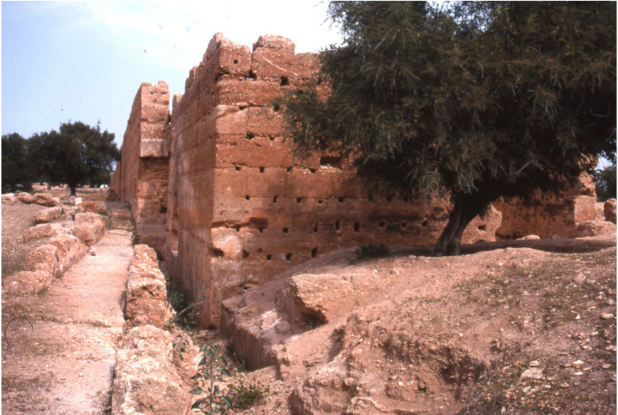
Fig.7 - Logement de la roue hydraulique et canal de fuite ( Cliché Gérard Giuliani )
