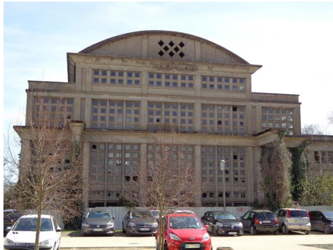
Laneuveville-devant-Nancy Chaufferie centrale thermique de la papeterie de la Rochette Photo M A Sonrier.
