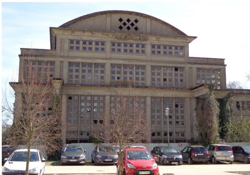
Figure 6. Laneuveville-devant-Nancy (Meurthe-et-Moselle), chaufferie centrale de la papeterie de la Rochette, ins. MH en 2012. M.-A. Sonrier
